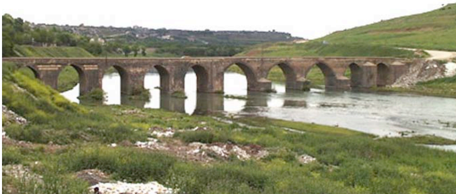
Diyarbakir (Amida), römische Brücke über den Tigris
